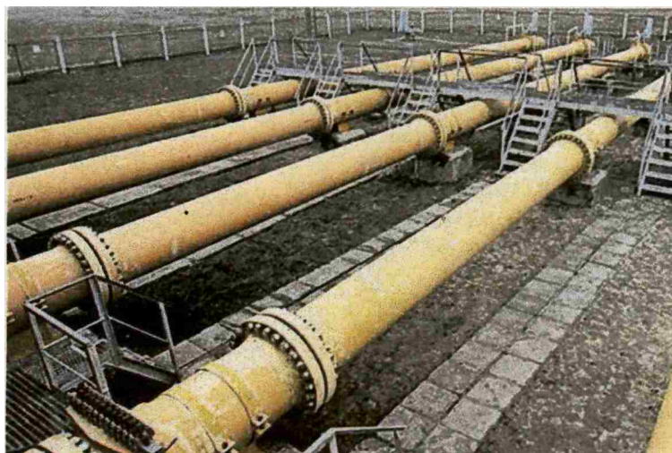
Novca za izgradnju gasovoda nema
