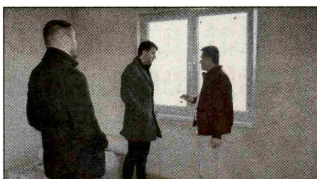
Obavljeni radovi na 11 stambenih jedinica
